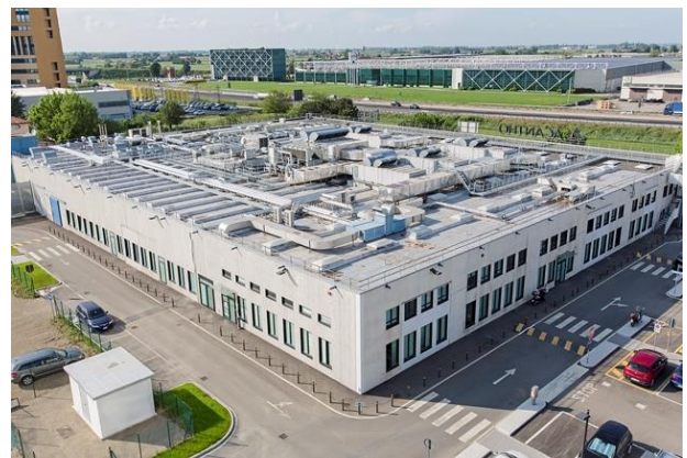
Figura 1. Fabbricato oggetto d'intervento.
