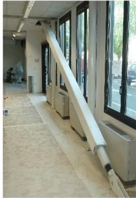
Figura 14. Particolare di cantiere.
