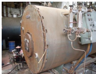
Figura 12, 13 – Esempi di usi di amianto nell'industria dei trasporti. Da sinistra: ferodi di freni per veicoli, guarnizioni di caldaie
