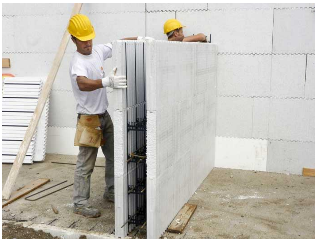
Figura 3 – La posa in cantiere di elementi in EPS che costituiscono in sistema ICF-SAAD
