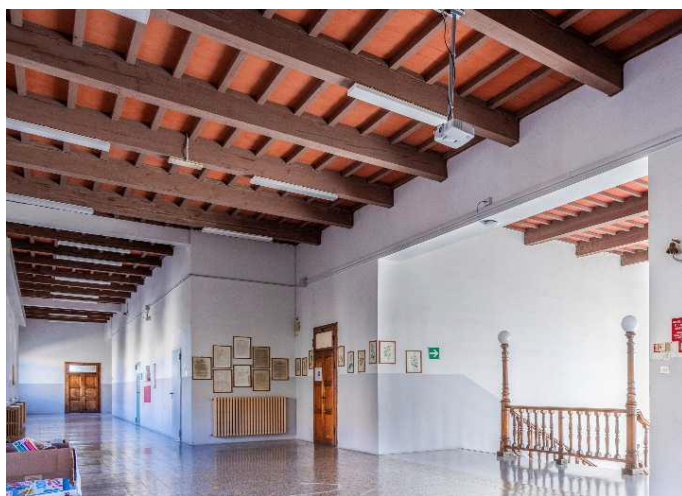
Figura 10 Atrio piano primo, visibile l'intradosso del solaio di sottotetto.
