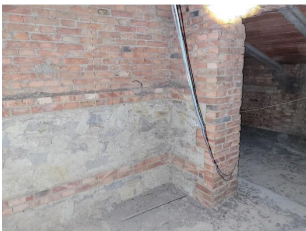
Figura 9 Muri di sottotetto.
