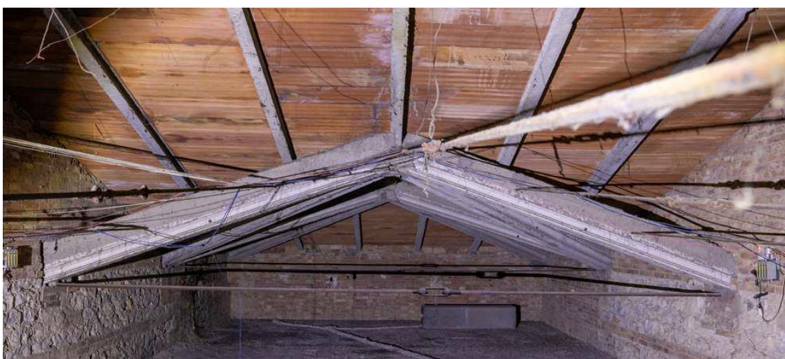
Figura 8 Intradosso solaio di copertura (tiranti in acciaio).
