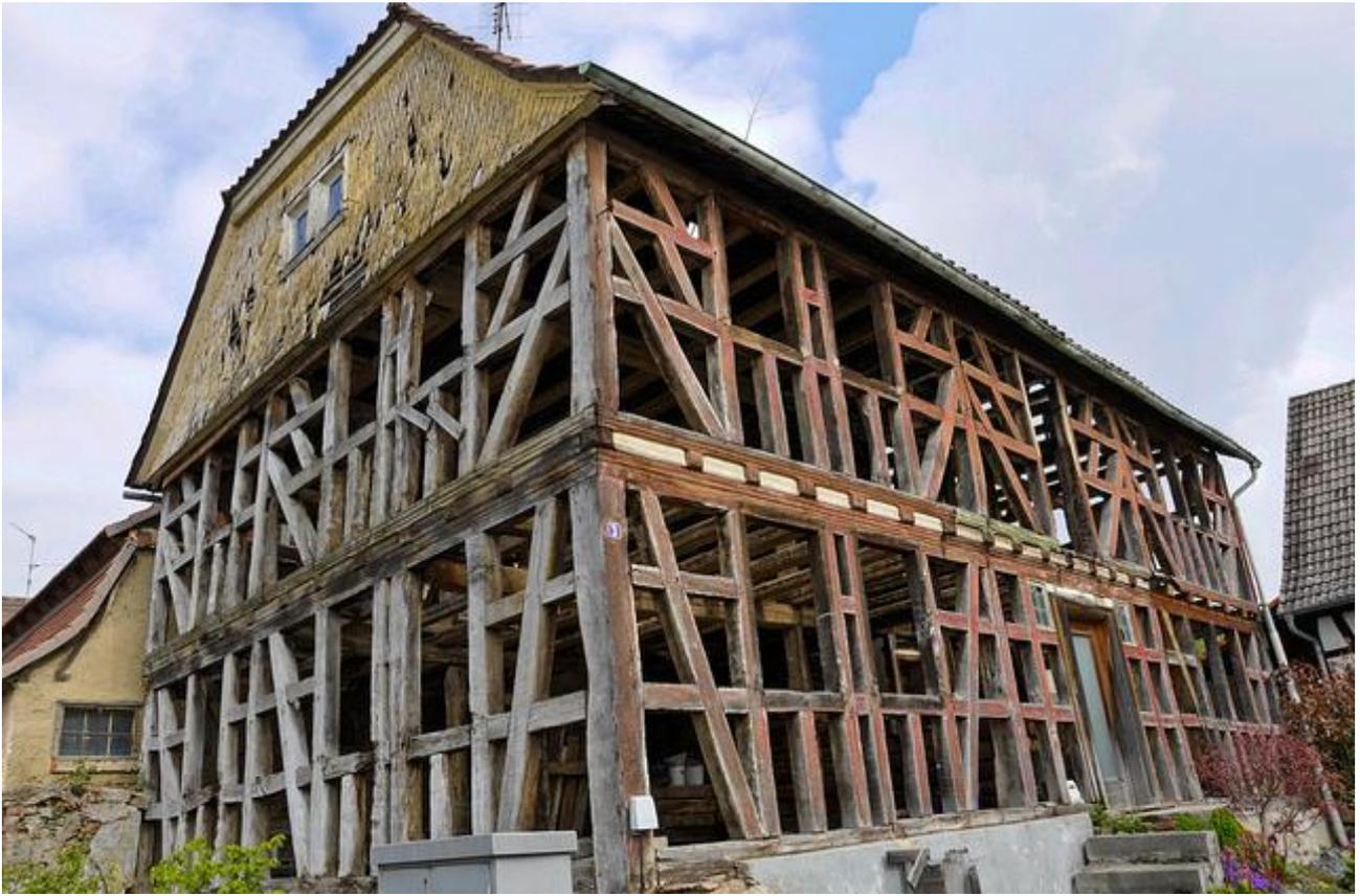
L'avanzamento della costruzione era programmato piano per piano, il primo solaio serviva da piattaforma per costruire il piano superiore.
