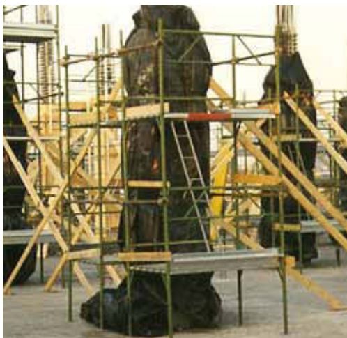
Fig. 6 – Copertura con materiale coibente.
