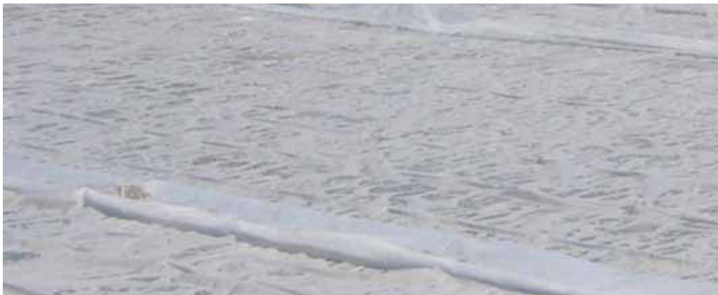
Fig. 5 – Copertura con teli di polietilene.
