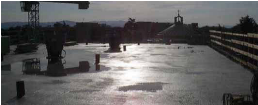
Fig. 3 – Superficie costantemente bagnata.
