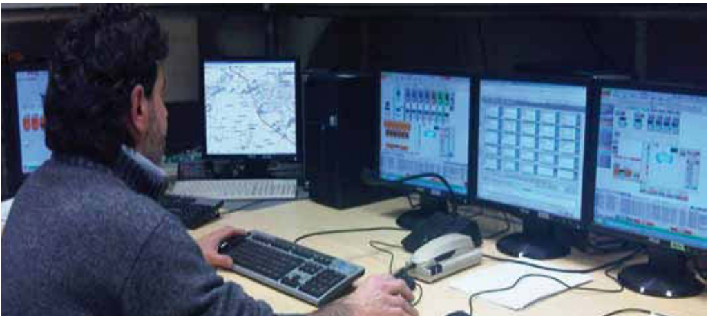
Fig. 3 - Cabina di comando per centrale di betonaggio.
