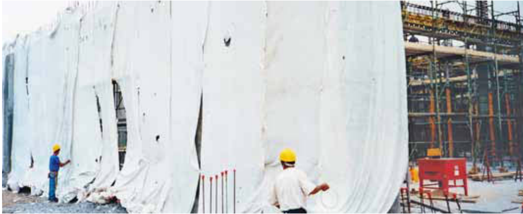
Fig. 7 – Geotessuto tenuto costantemente umido.
