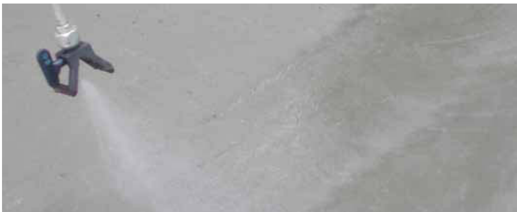
Fig. 9 – Applicazione a spruzzo di un agente stagionante.
