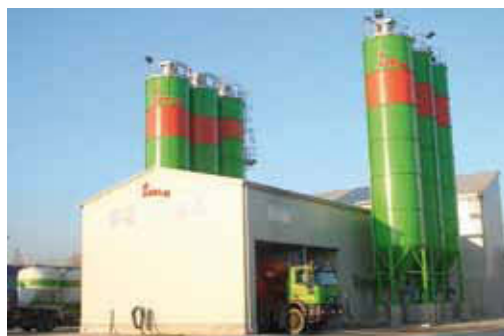
MOSOLE CALCESTRUZZI S.r.l. Camponogara (VE) Impianto tipo: Duplex 6 Produzione: 220 mc/h
