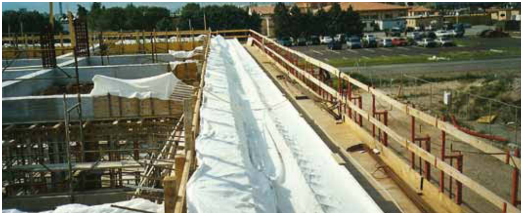
Fig. 8 – Geotessuto tenuto costantemente umido.
