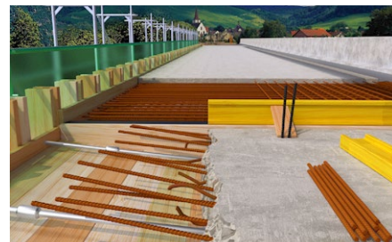
Riprese di getto in infrastrutture
