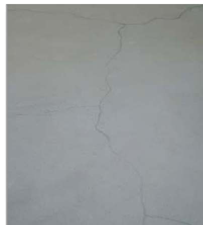
Fig. 7.1 - Massetto fessurato
