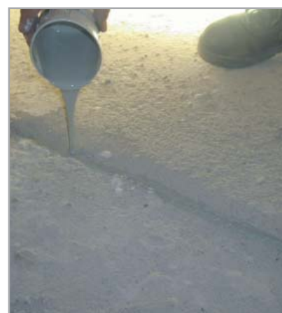
Fig. 7.3 - Sigillatura delle lesioni con EPORIP
