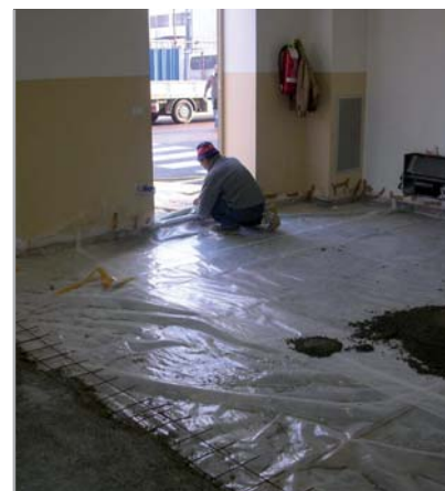
Fig. 4.3 - Realizzazione di massetto desolidarizzato su foglio di polietilene
