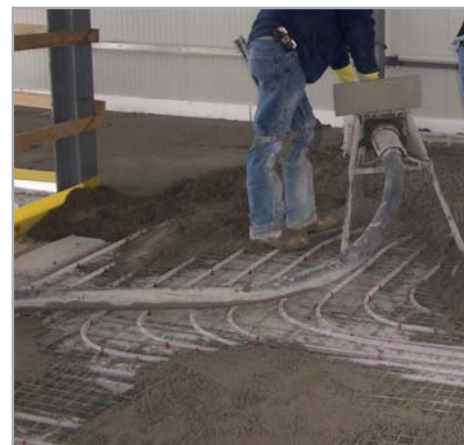
Fig. 4.9 - Realizzazione di massetto incorporante le serpentine di un impianto radiante
