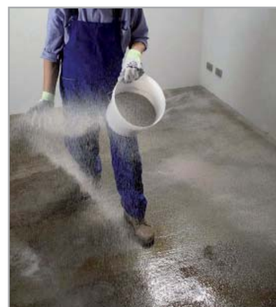
Fig. 7.12 - Spaglio di sabbia sulla superficie del massetto a seguito dell'applicazione di PRIMER MF
