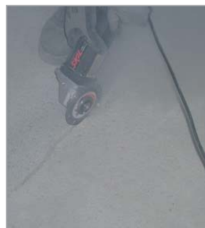
Fig. 7.2 - Apertura delle fessurazioni del massetto con flessibile
