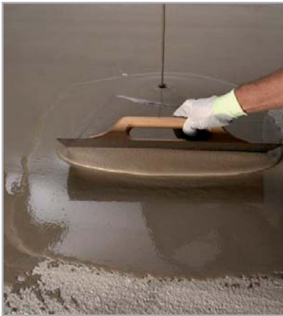
Fig. 7.14 - Regolarizzazione della planarità del massetto tramite stesura di ULTRAPLAN
