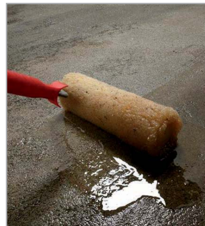
Fig. 7.11 - Applicazione di PRIMER MF sulla superficie di un massetto
