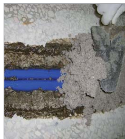
Fig. 7.8 - Riempimento della lesione con MAPEFLOOR EP19
