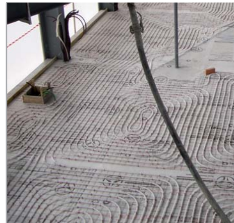
Fig. 4.8 - Predisposizione di serpentine per impianto radiante a pavimento
