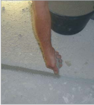
Fig. 7.4 - Applicazione di sabbia sulla superficie di EPORIP fresco.
