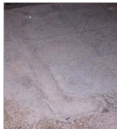
Fig. 6.3 - Sigillatura di una traccia in una pavimentazione esistente mediante applicazione di boiacca di adesione sulle superfici di contatto tra esistente e ripristinato
