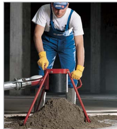
Fig. 5.1 - Alimentazione dell'impasto di TOPCEM/ TOPCEM PRONTO con pompa
