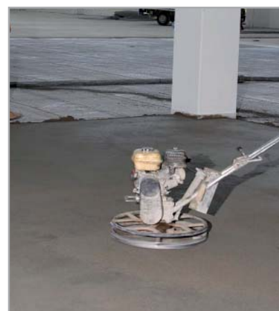
Fig. 6.7 - Finitura con disco d'acciaio della superficie del massetto
