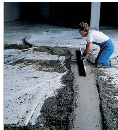
Fig. 6.1 - Formazione delle fasce di livello
