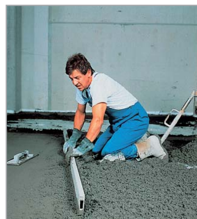
Fig. 5.2 - Staggiatura dell'impasto di TOPCEM/TOPCEM PRONTO
