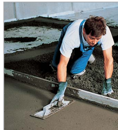
Fig. 6.6 - Finitura con frattazzo della superficie del massetto
