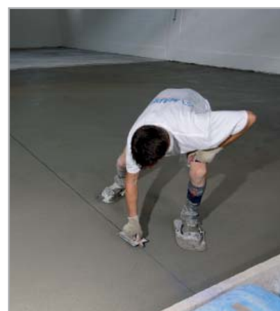
Fig. 6.8 - Realizzazione dei giunti di controllo nel massetto
