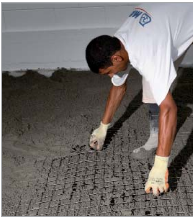
Fig. 6.5 - Posizionamento di rete metallica zincata nella mezzeria del massetto
