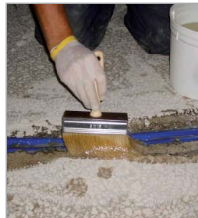
Fig. 7.7 - Applicazione di boiaccia di adesione a base di resina epossidica (PRIMER MF)
