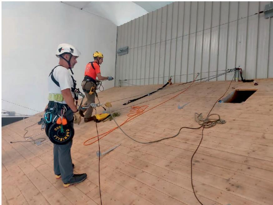
Figura 7.2.1-9 - Sistema di posizionamento sul lavoro
