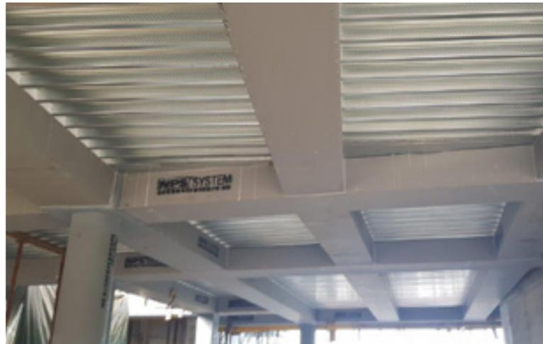
Ideale per l'impiego in edifici alti così come per interventi di ristrutturazione o sopraelevazioni grazie al limitato peso proprio delle strutture NPS®<sub>L</sub>.
