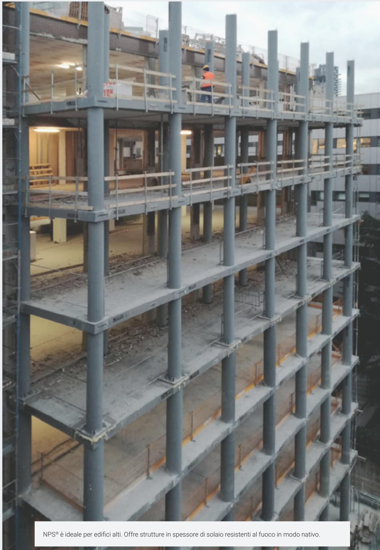
NPS® è ideale per edifici alti. Offre strutture in spessore di solaio resistenti al fuoco in modo nativo.
