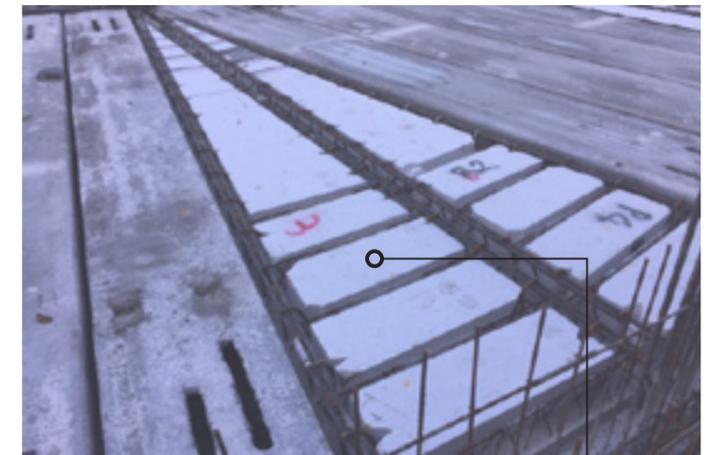
Travi NPS® abbinata a solaio Alveodalla che si adatta al perimetro circolare della struttura
