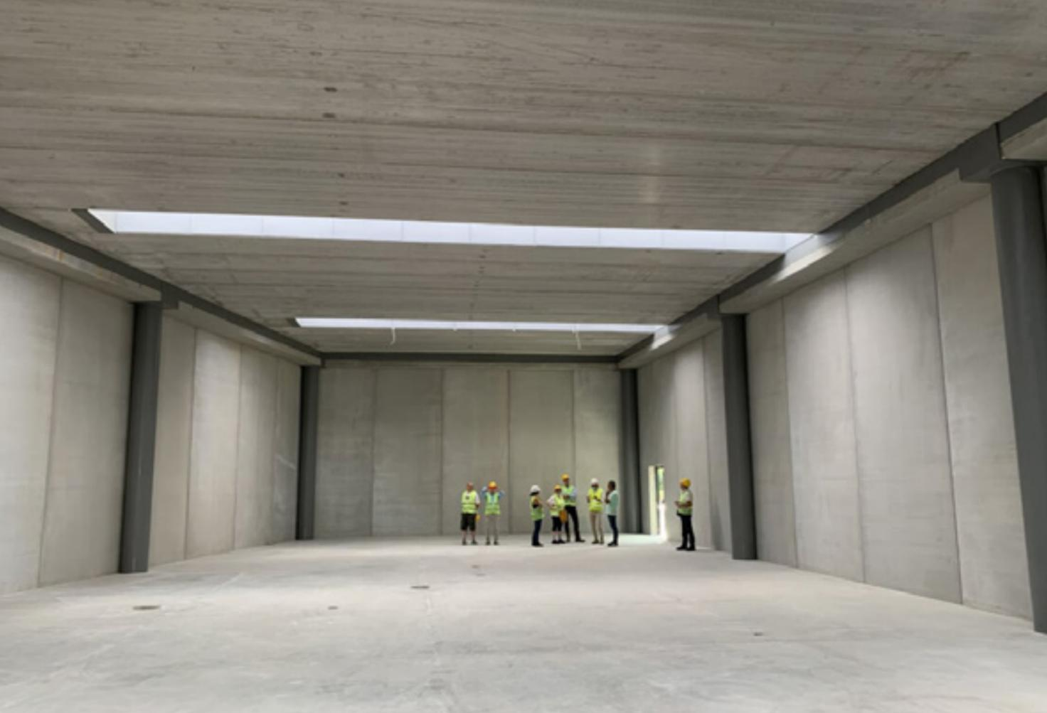
Λ Le travi NPS® CLS appoggiate su pilastri PDTI® hanno consentito l'abbinamento a solai alveolari lunghi oltre 14 metri.
