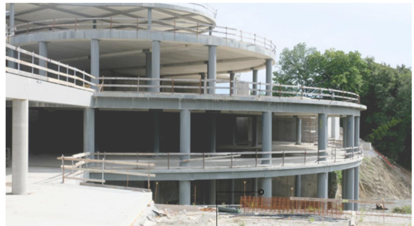
Pilastri PDTI® alti 10 metri, realizzati in un unico tronco.
