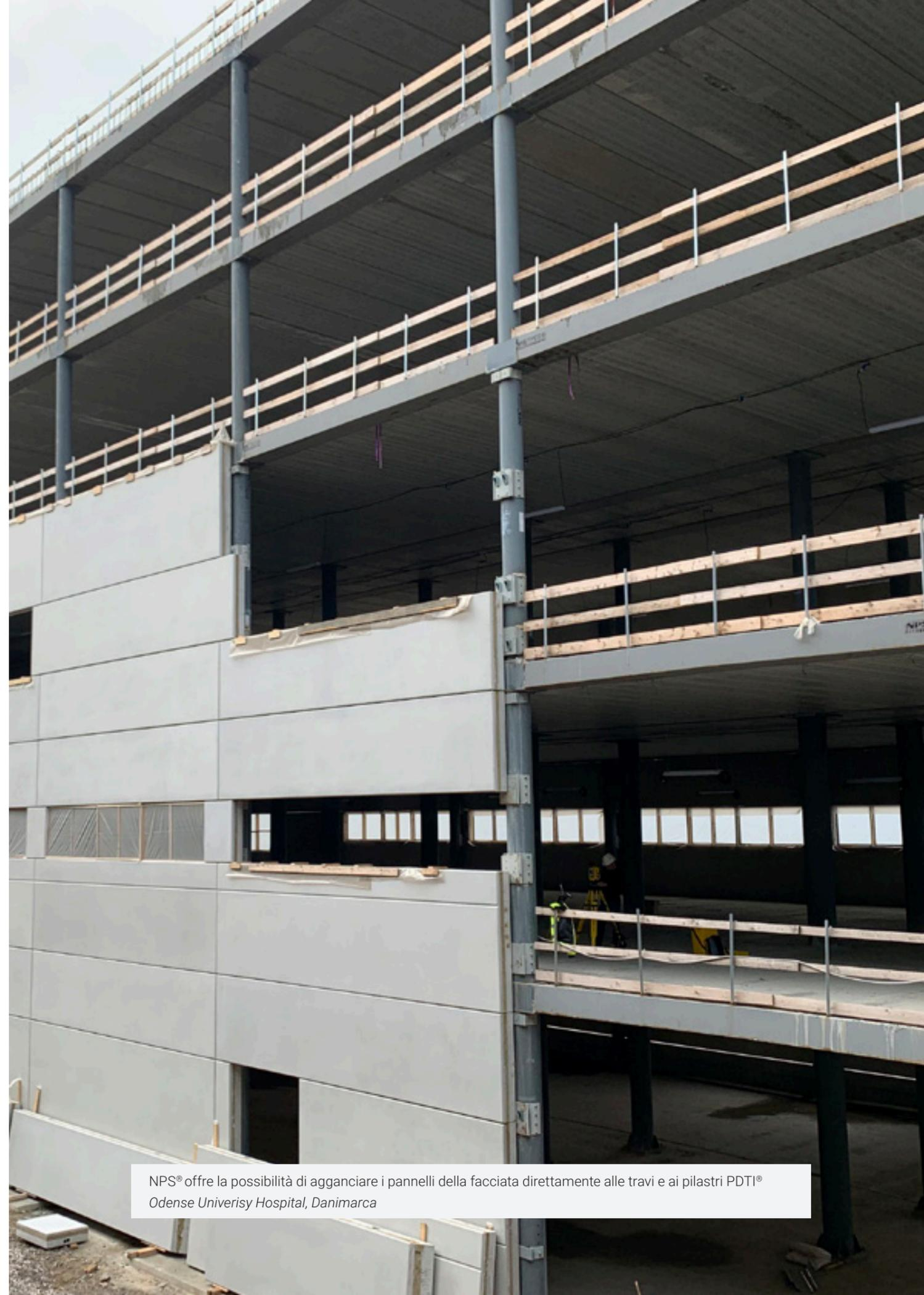
NPS® offre la possibilità di agganciare i pannelli della facciata direttamente alle travi e ai pilastri PDTI®
