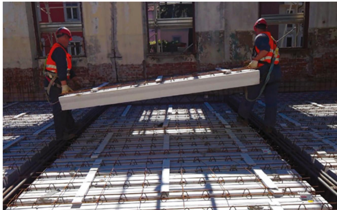
Grazie al suo peso a secco di 45 kg/m<sup>2</sup>, Airfloor™ consente la facile movimentazione in cantiere.
