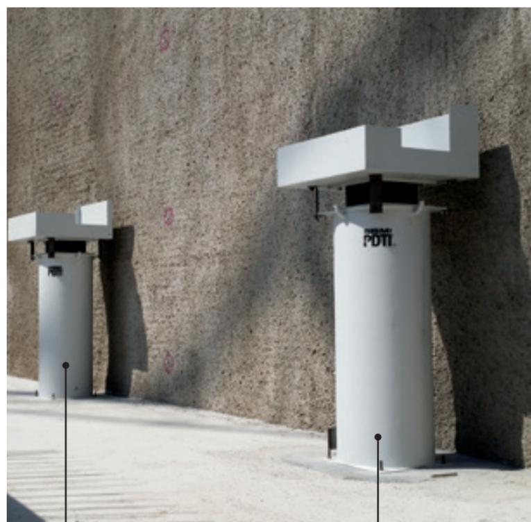
Pilastri Sismi PDTI® impiegati per la sede direzionale del gruppo farmaceutico Angelini. I pilastri Sismi PDTI® isolano l'edificio alla base garantendo un'ottima risposta sismica.
