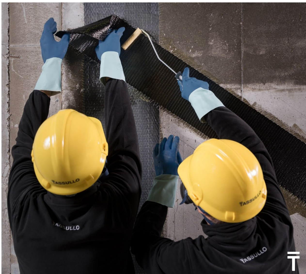
Figura 6. Applicazione del tessuto CARBON pre-impregnato, in un sistema FRP
