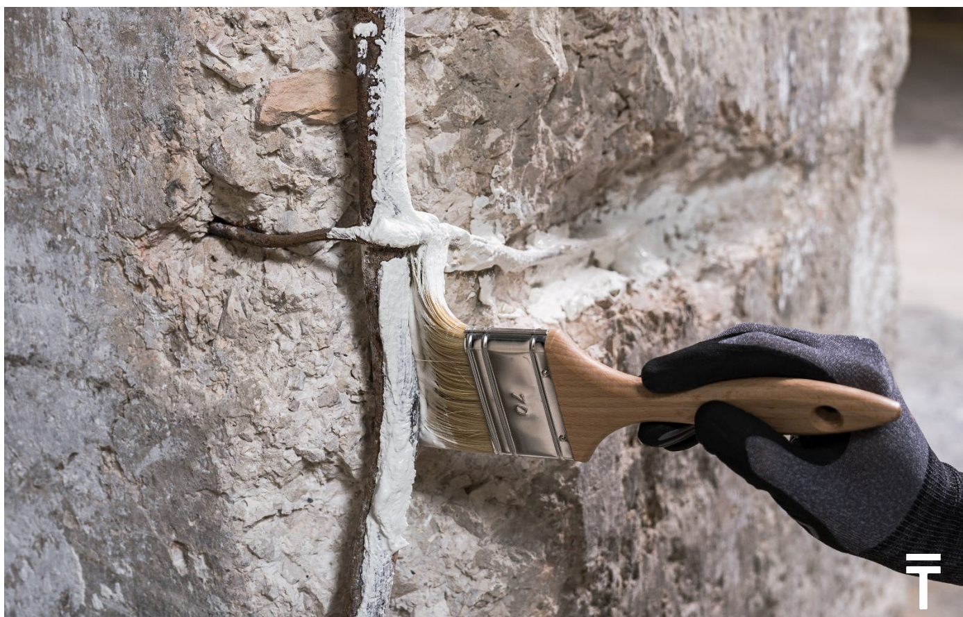
Figura 4. Applicazione del passivante RENOVA OXI
