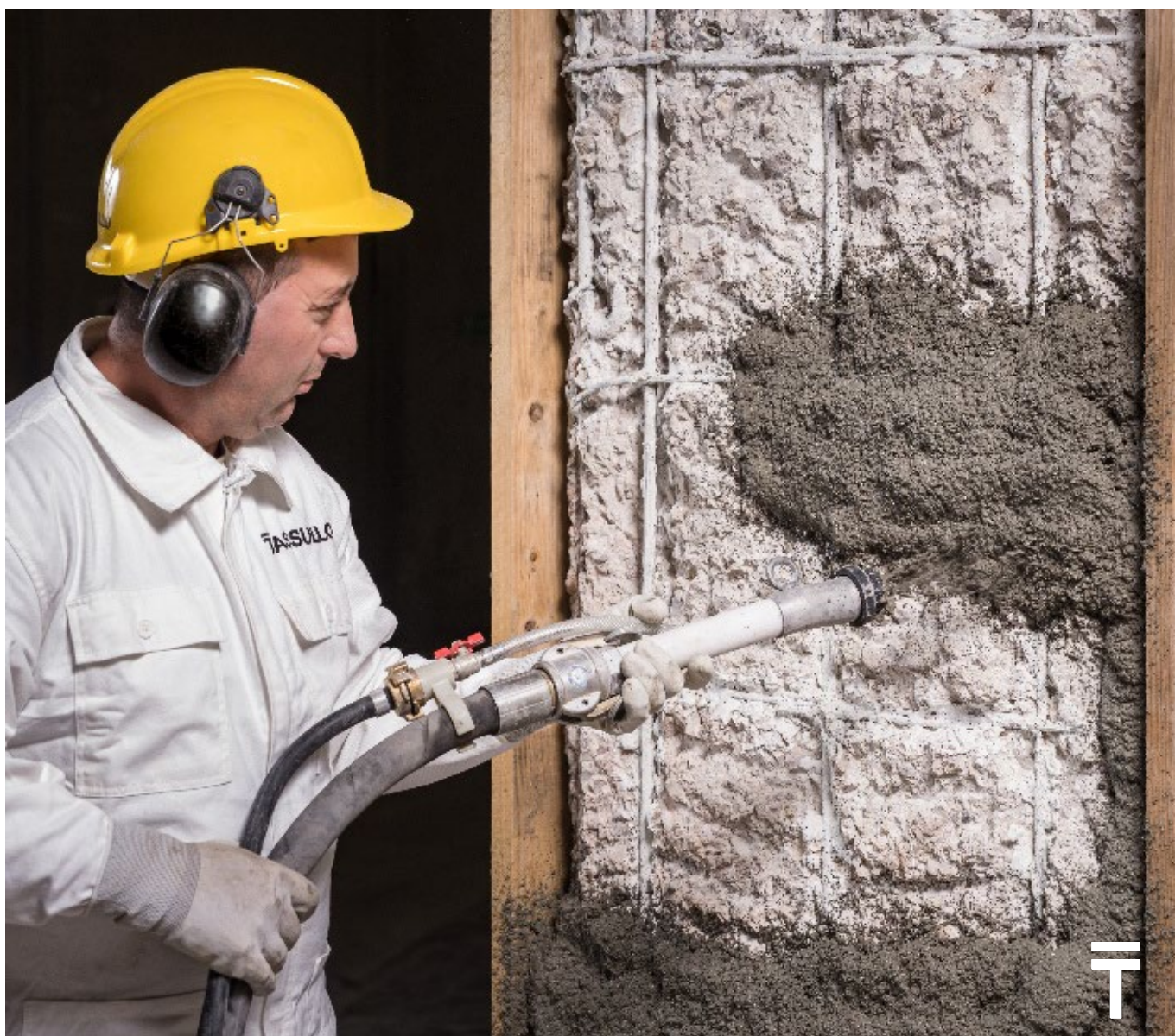
Figura 5. Applicazione di RENOVA MEC, a seguito del passivante RENOVA OXI, per il ripristino volumetrico di un pilastro in calcestruzzo armato.
