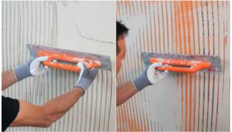
Applicazione della rasatura
