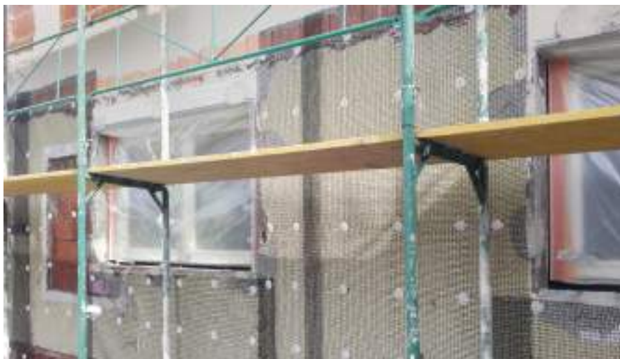
Esecuzione del foro e inserimento del tassello
