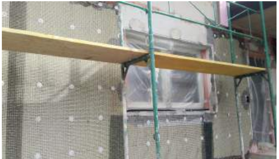
Listelli di battuta sugli spigoli di finestre
