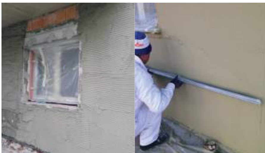
Applicare l'intonaco a macchina
