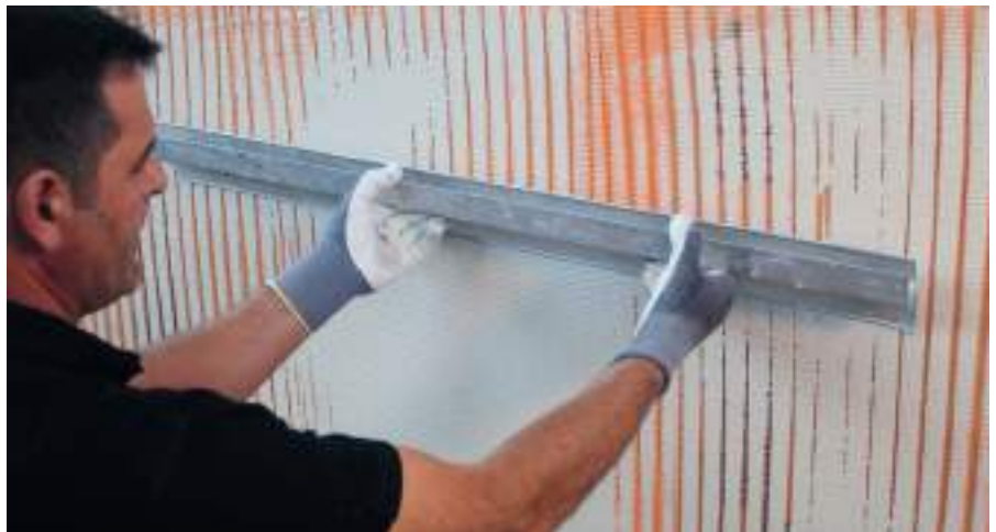
Livellamento della rasatura
