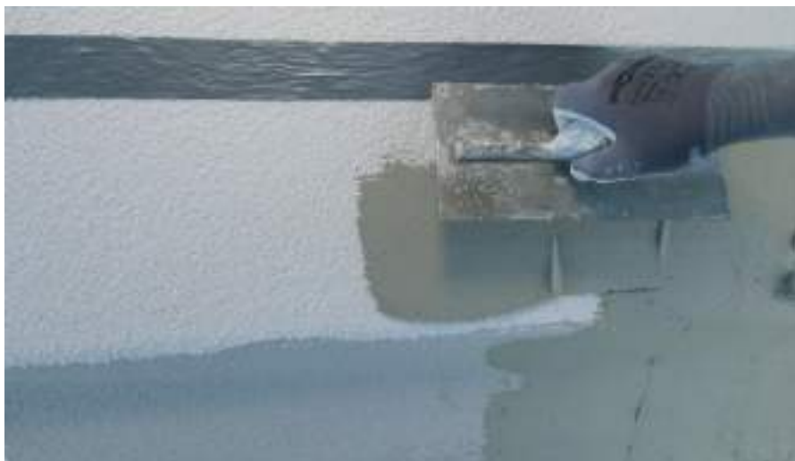
Impermeabilizzazione zoccolatura controterra
