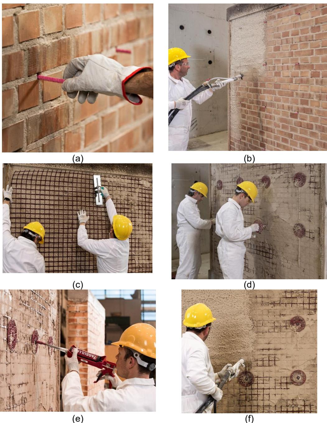
**Figura 4.** Procedura applicativa del sistema ARMIS ALL-IN-ONE: a) taglio di ARMIS STRONG BAR in misura; b) inserimento delle barre tagliate nei fori con funzione di marcaforo; c) applicazione del primo strato di malta strutturale; d) posizionamento della rete; e) pre-assemblaggio del connettore e inserimento nei fori precedentemente riempiti di ancorante; f) fissaggio definitivo del connettore ARMIS ALL-IN-ONE mediante RESINA VE.
